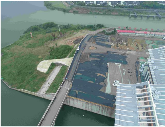
管理区土工布覆盖
