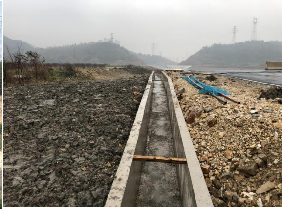
排水沟及绿化覆土
