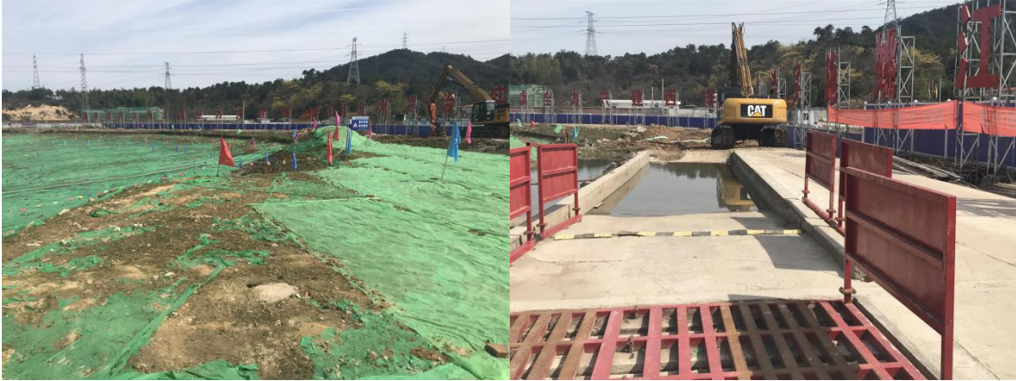
调节池开挖临时苫盖
